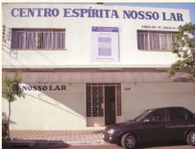
Fachada atual do Centro Espírita Nosso Lar
